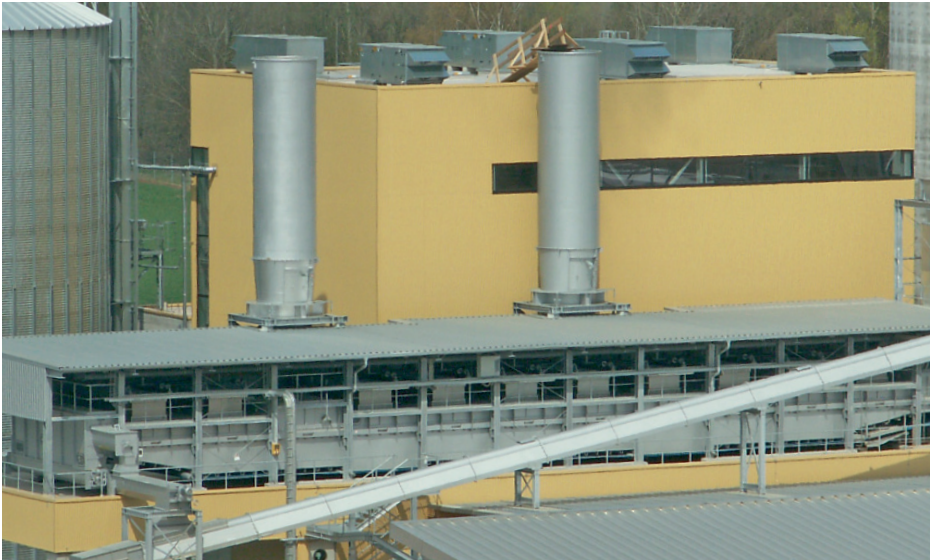
Einen Swiss Combi Kuvo-Bandrockner mit 205 m 2 setzt Binderholz in Kösching/DE ein
