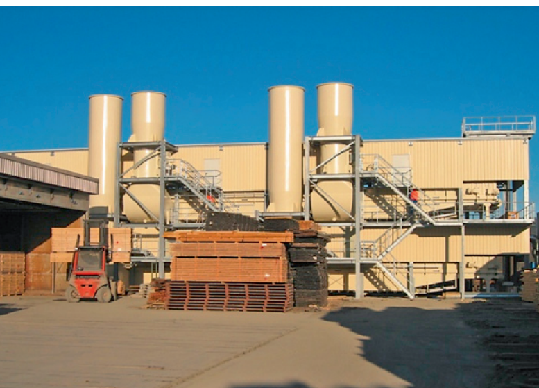
Übereinander angeordnet: Bei IBV in Belgien wurden zwei Swiss Combi Kuvo-Bandrockner mit jeweils 205 m 2 installiert
